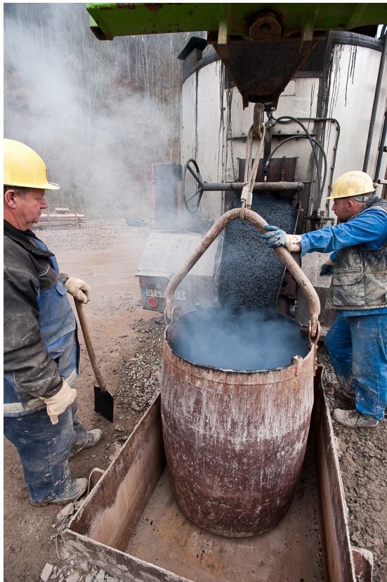
Abbildung 2: Befüllung des Förderkübels mit Gussasphalt (Foto: Uwe Glaubach)
