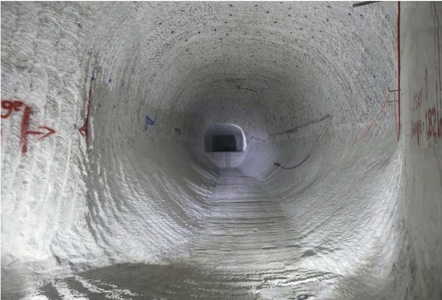
Schachtanlage Asse: Nachschnitt am Standpunkt der Strömungsbarriere SB-725-3
