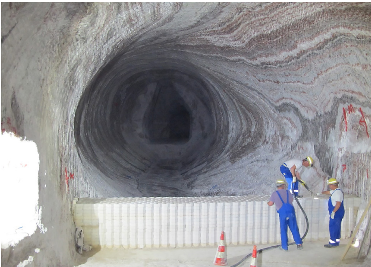
Nachschnittarbeiten während der Vorbereitung des Standortes für die Strömungsbarriere SB-725-3
