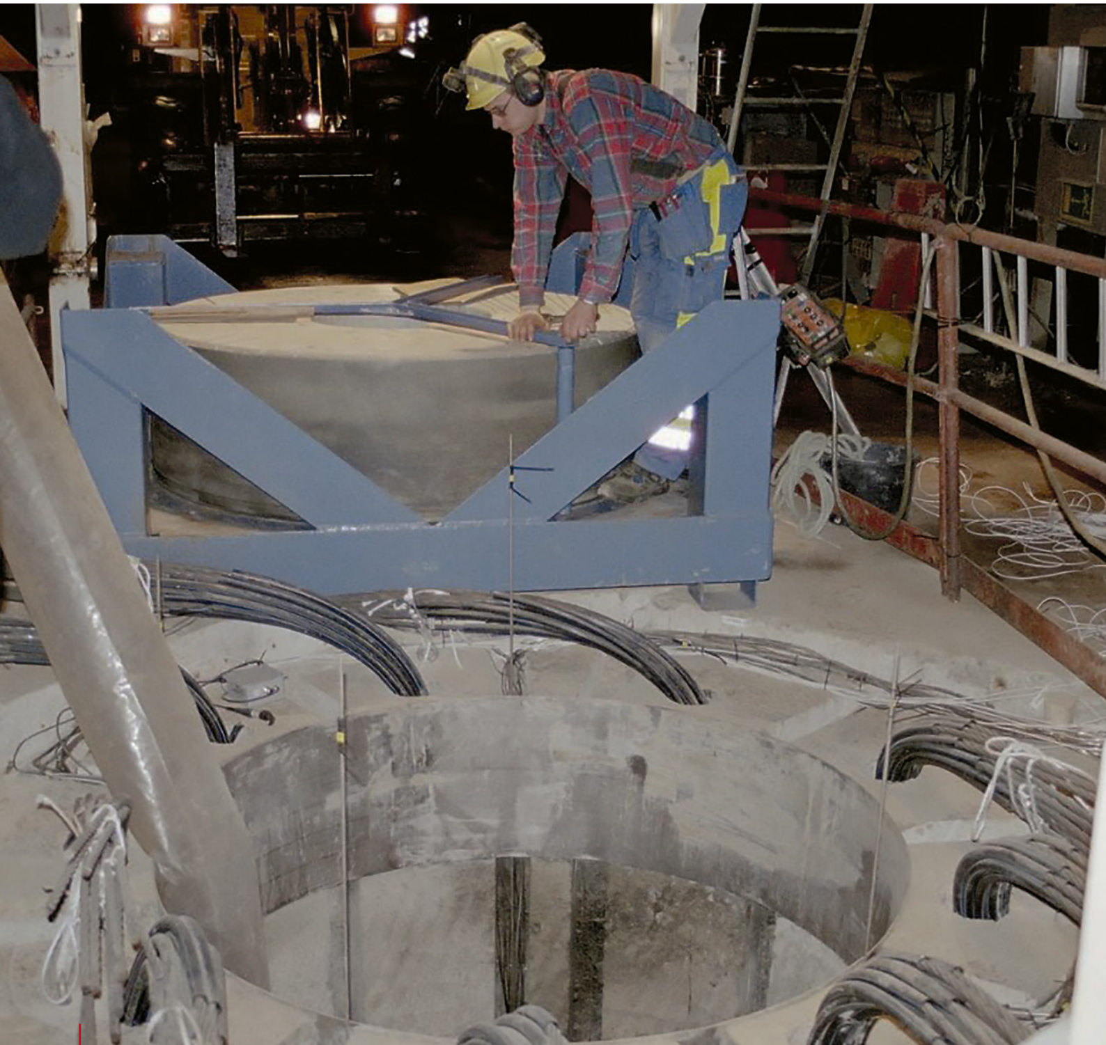
In-situ-Versuch zum Einbau des Bentonit-Buffers im Untertagelabor in Äspö (Quelle: SKB)
