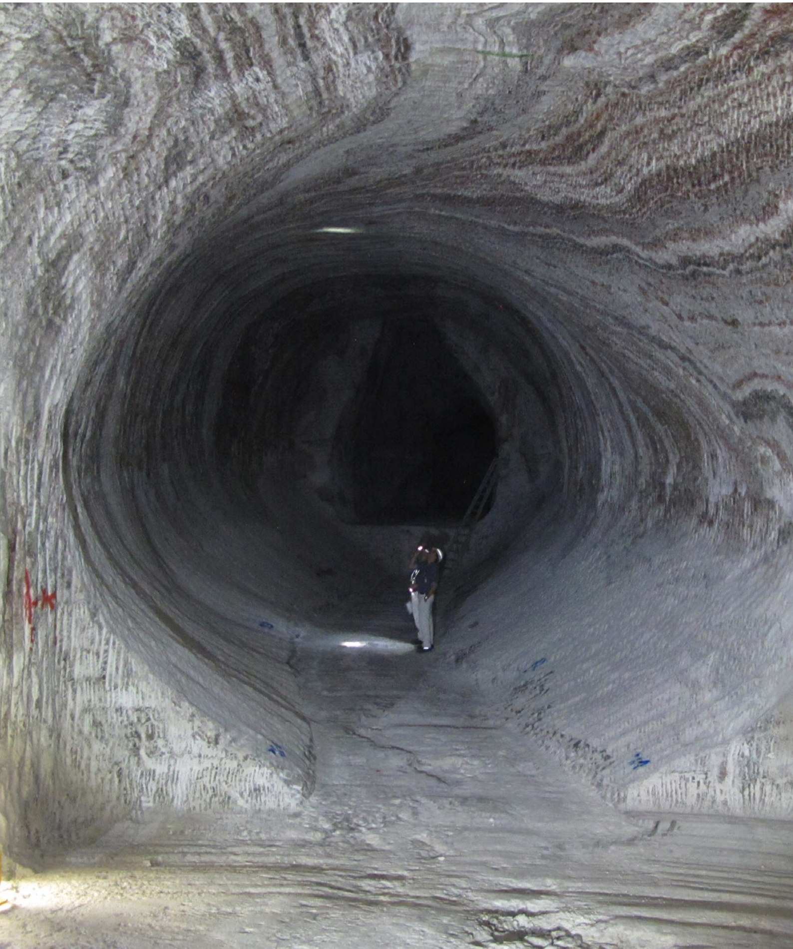
Nachgeschnittene Einbaulokation einer Strömungsbarriere auf der Asse
