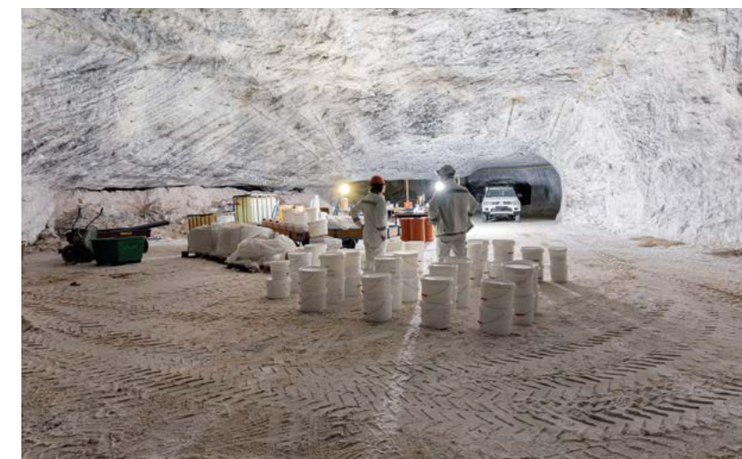
Untertägiges Baustofflabor im Endlager Morsleben
