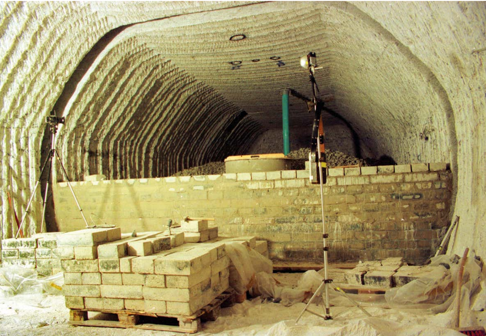
Schalungsmauer für die Errichtung eines Verschlussbauwerkes, Schachtanlage Asse
