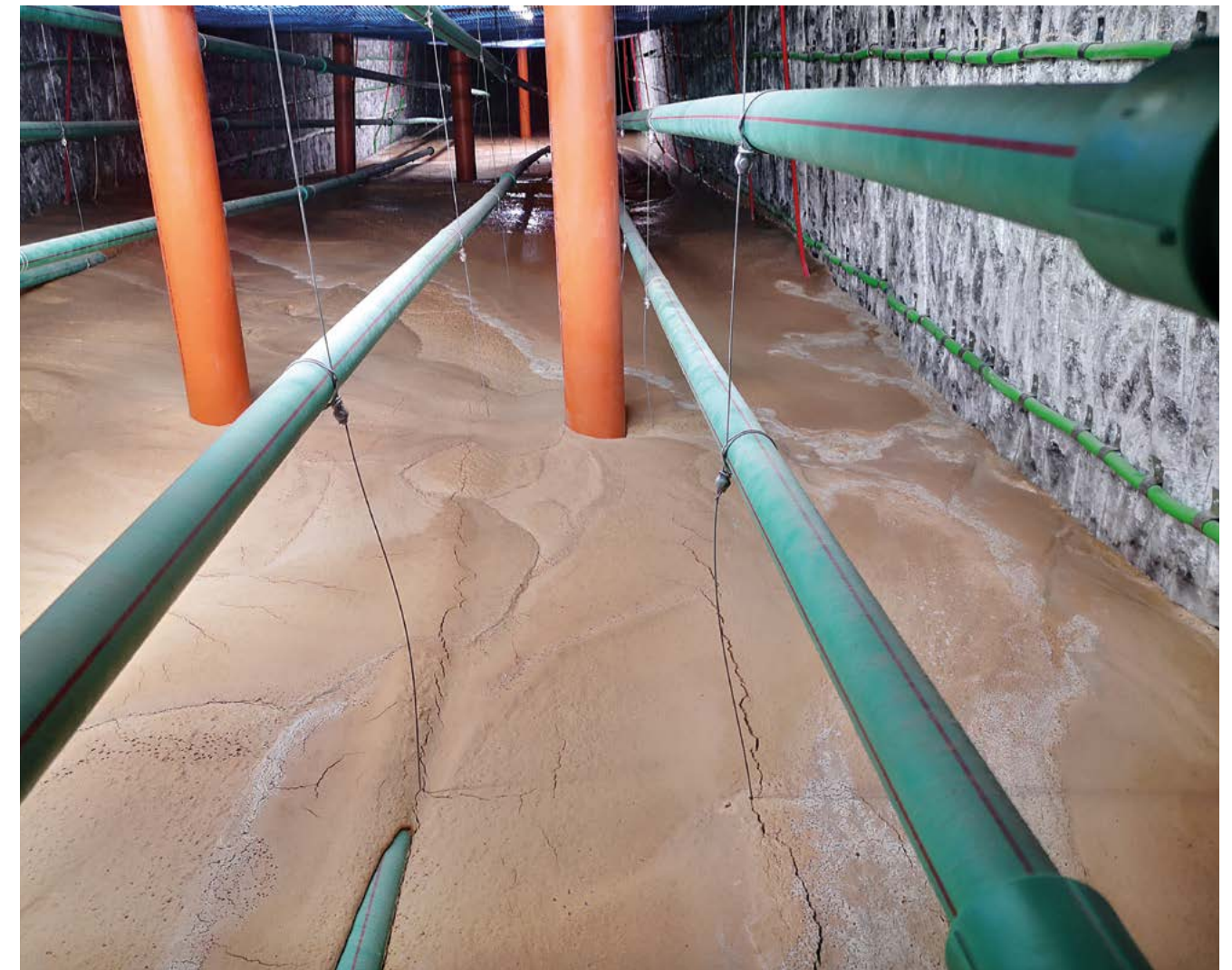
Betonage des Halbdamms in der Grube Teutschenthal
