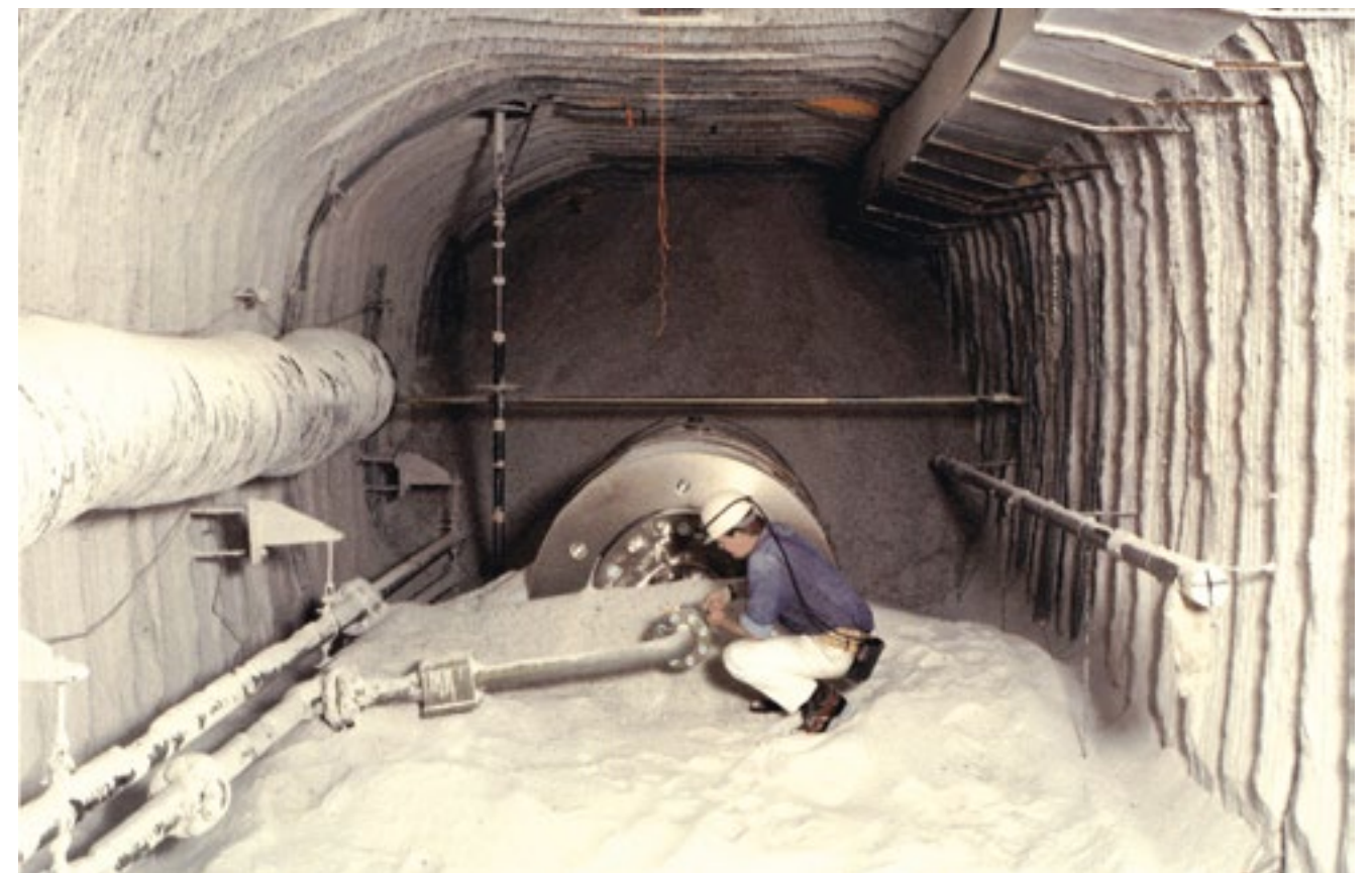
Asse: Repräsentativer In-situ-Versuch zur Untersuchung der Endlagerung wärmeentwickelnder radioaktiver Abfälle in Salzformation
