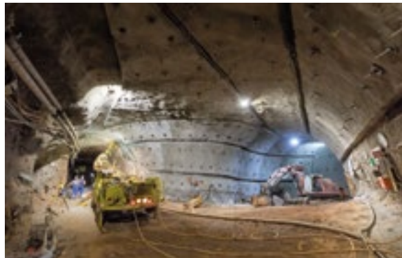
Konrad: Arbeiten zur Umrüstung in ein Endlager
