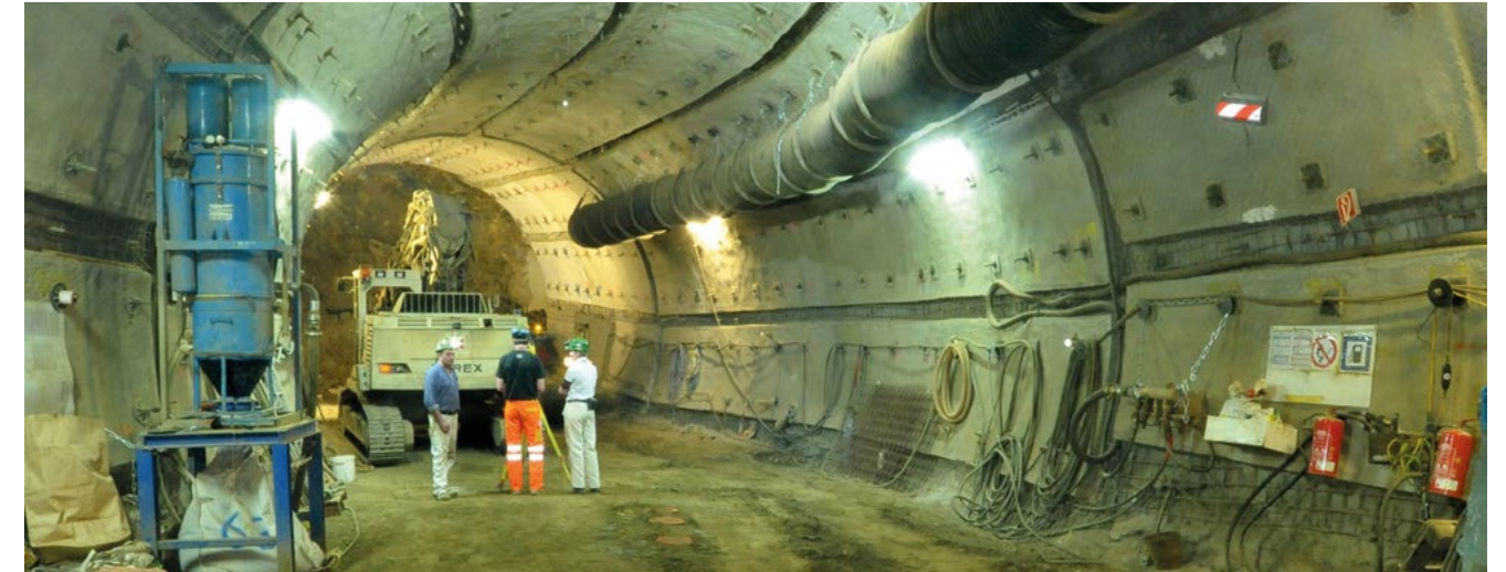
Ausbau in tonig-mergeligen Gesteinen im Füllort des Endlagers Konrad
