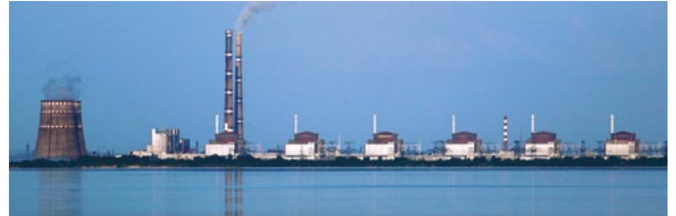
Kernkraftwerk Saporischschja, SO Ukraine (Quelle: ENERGOATOM)
