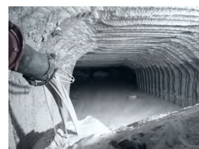
Einbringen von Sorelbeton als Massensbeton in der Asse
