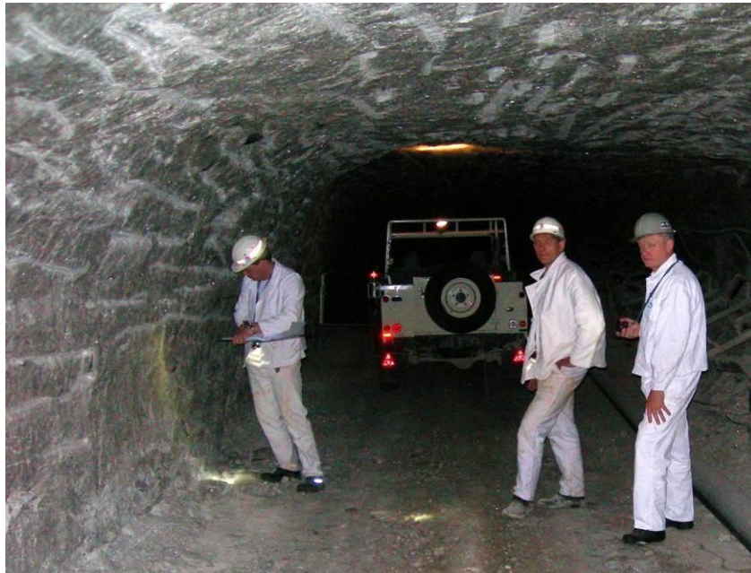
Abbildung 4-2: Versuchsstandort im C2 – Bandberg, Werk Niedersachsen – Riedel, mit deutlichen Sohlhebungen und großflächigen Abschalungen am rechten Stoß.
