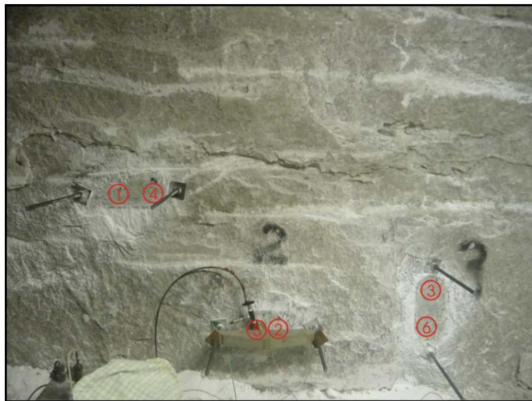
Abbildung 4-7: Lage der Untersuchungsbereiche und der einzelnen Messstellen der mobilen Oberflächenpacker am Südost-Stoß. Die Darstellung zeigt die bereits angeschliffenen Oberflächen inklusive der gestoßenen Gebirgsanker.
