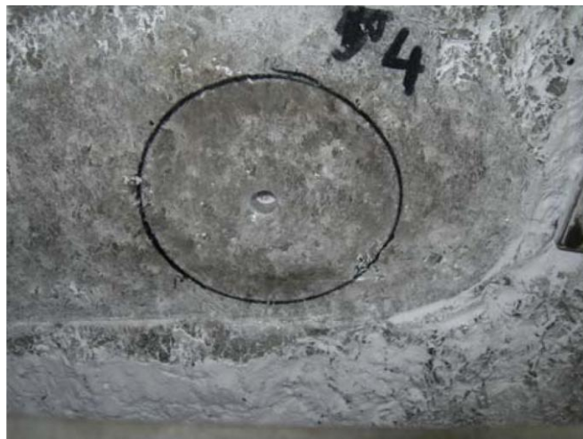
Abbildung 4-9: Messstelle OFP4 nach Herstellung des Injektionskanals.
