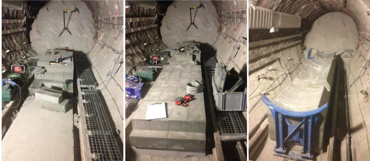
Abbildung 39: Manuell erstelltes Bentonitauflager im FE-Experiment der NAGRA (Köhler et al., 2015)
