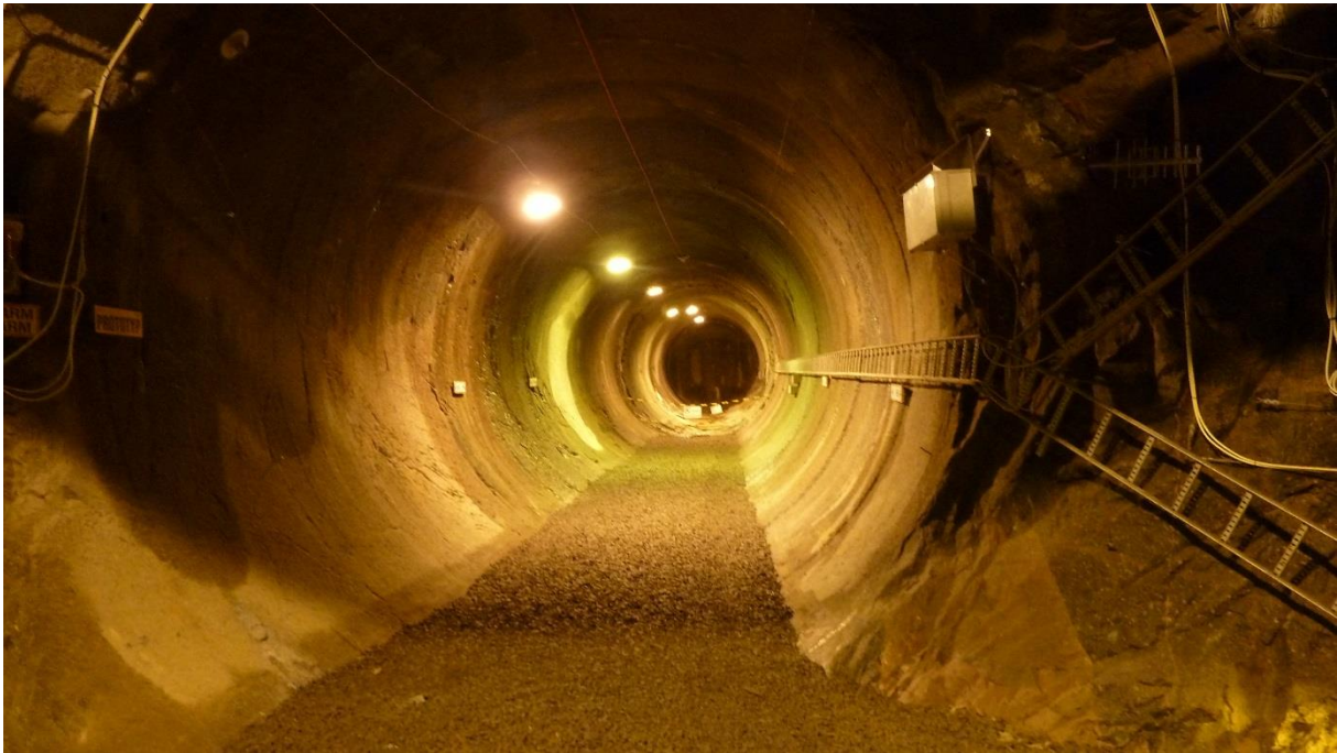
Abbildung 53: (Unverfüllte) Pileteinlagerungsstrecke für mehrere KBS-3-Behälter (KBS-3-V-Konzept) in 460 m Tiefe im Untergrundlabor Äspö, nahe Oskarshamn [617].
