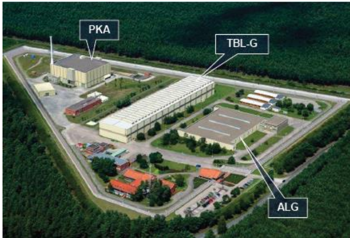
Abbildung 7: Die obertägigen Anlagen in Gorleben mit Pilot-Konditionierungsanlage (PKA), Transportbehälterlager (TBL) und Abfalllager (AL) [93].
