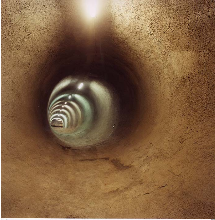
Abbildung 3-4: Zweischaliger, bewehrter und wasserundurchlässiger Spritzbetonausbau im Dogger in ca. 1000 m Teufe
