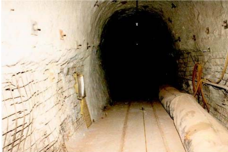
Abbildung 3-2: Schachanlage Konrad - Ehemalige Untersuchungsstrecke (Teufe – 343 m) mit Anker-/ Spritzbetonausbau
