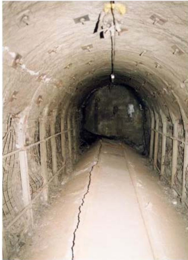
Abbildung 3-3: Schachanlage Konrad - Ehemalige Untersuchungsstrecke (Teufe – 541 m) mit geschraubten Stahlbögen und Anker-/Spritzbetonausbau in der Firste
