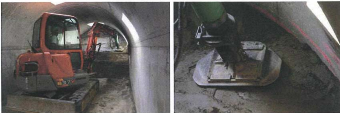
Abbildung 3-37: Frankreich – Versuche zur Streckenverfüllung im ULR Bure Meuse/Haute-Marne /3-30/
