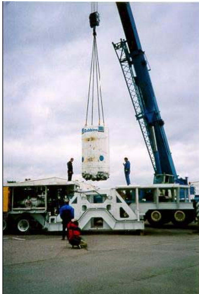
Abbildung 4-57: Einsetzen der Robbins SBM 1.8 in den Trailer [SKB 2002]
