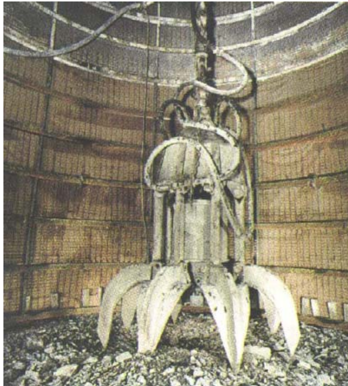
Abbildung 5-8: Mehrschalengreifer [IfB 2008c]
