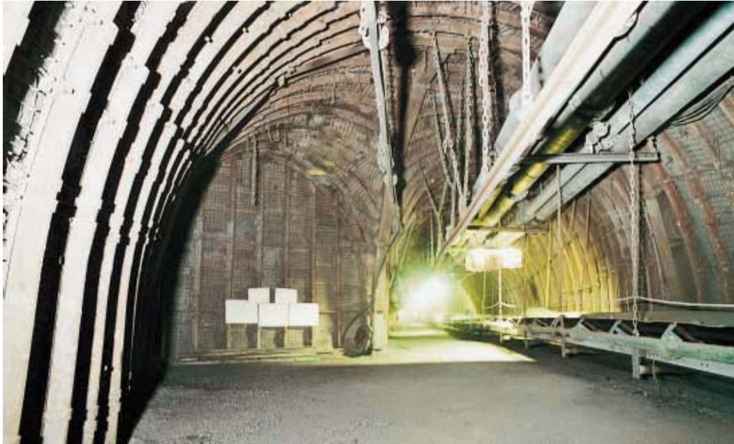
Abbildung 4-43: Abzweigbauwerk [Thyssen Schachtbau 2002a]
