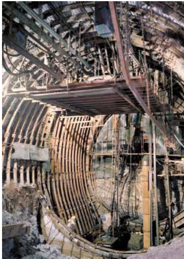
Abbildung 5-14: Herstellung Schachtglocke AV8 [Thyssen Schachtbau 2002a]
