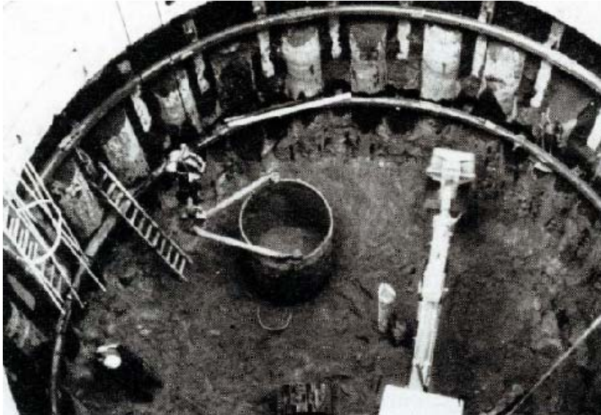
Abbildung 5-6: Bohrfahlverfahren [Reuther 1989]
