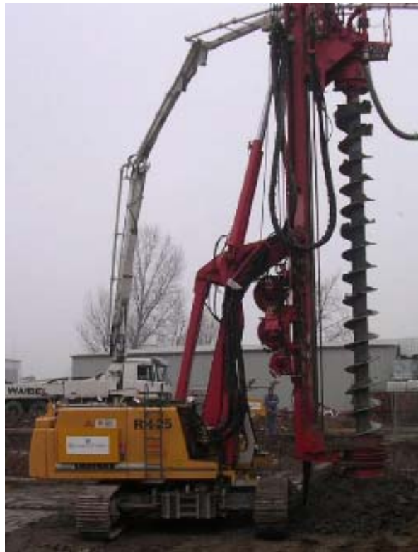
Abbildung 4-53: Schneckenbohranlage [Bilfinger Berger 2008]
