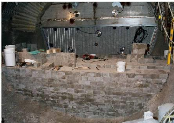
Abb. 3.6: TSX-Versuch zur Errichtung eines Dichtelementes im kanadischen Untertagelabor (Chandler et al. 2002).
