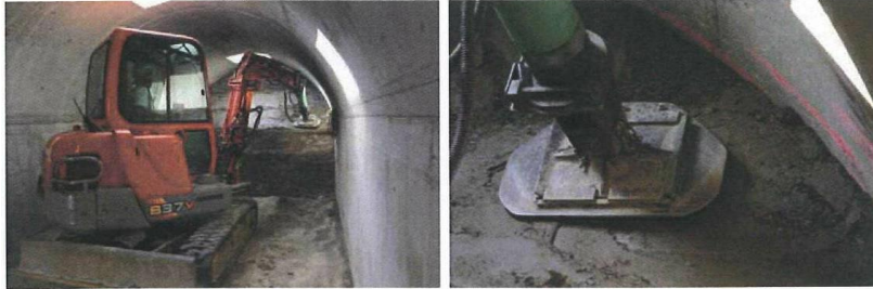
Abb. 3.8: Versuche zur Strecken- verfüllung im Untertagelabor Bure (Meuse/Haute-Marne, Frankreich)
