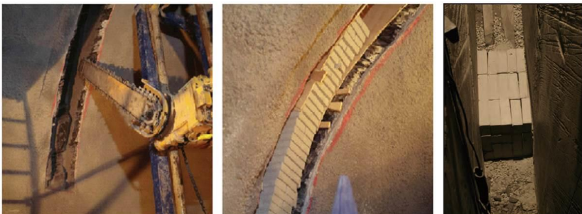
Abb. 3.35: Installation von Bentonitblöcken in ausgesägten Schlitz in den Streckenkontur (KEY experiment) im Meuse/Haute-Marne URL (ANDRA 2005)
