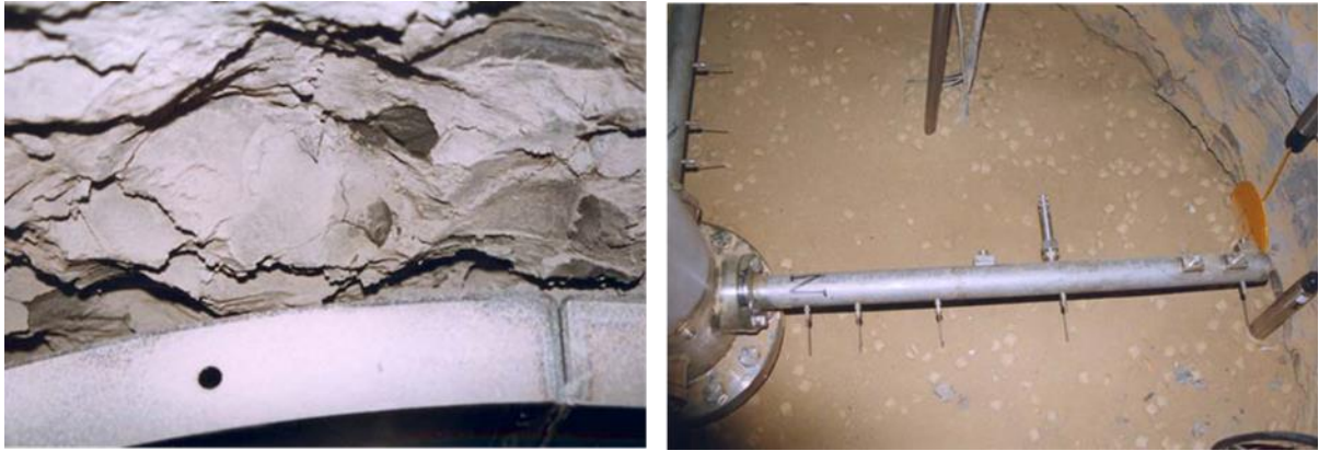
Abb. 3.22: Links: Temporärer Ausbau und Kontaktfläche des Wirtsgesteins am Dichtungstandort, rechts: Dichtelement während des Einbaus (van Geet et al. 2009)
