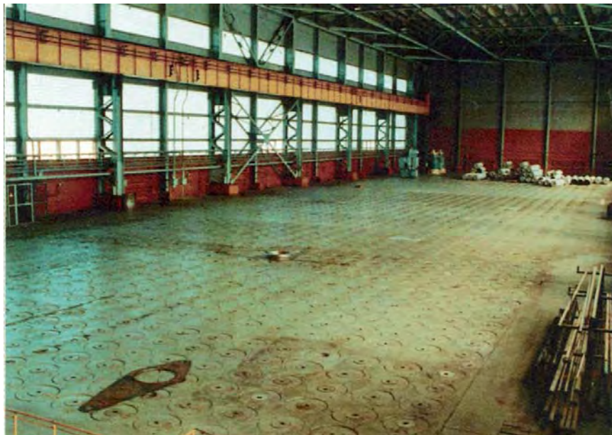
Abb. 1-5: Majak - Zwischenlager für verglaste HLW
